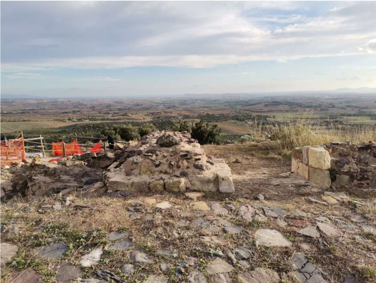
Fig. 21 - MONASTIR (SU) - Castello di Baratuli. Elementi cantonali in opera isodoma (foto G. Salis)
