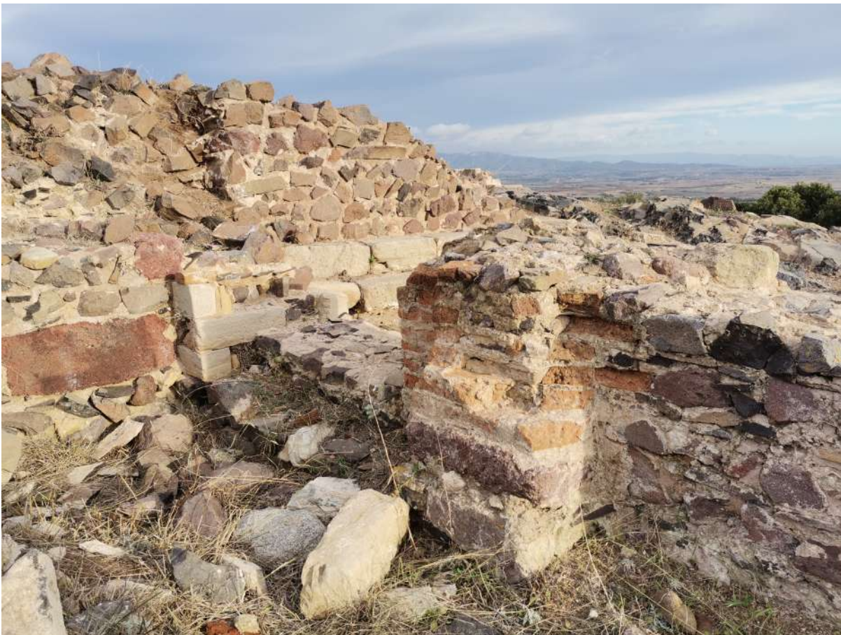
Fig. 25 - MONASTIR (SU) - Castello di Baratuli. Ingresso del vano E, con tratti di mattoni in opera (foto G. Salis)
