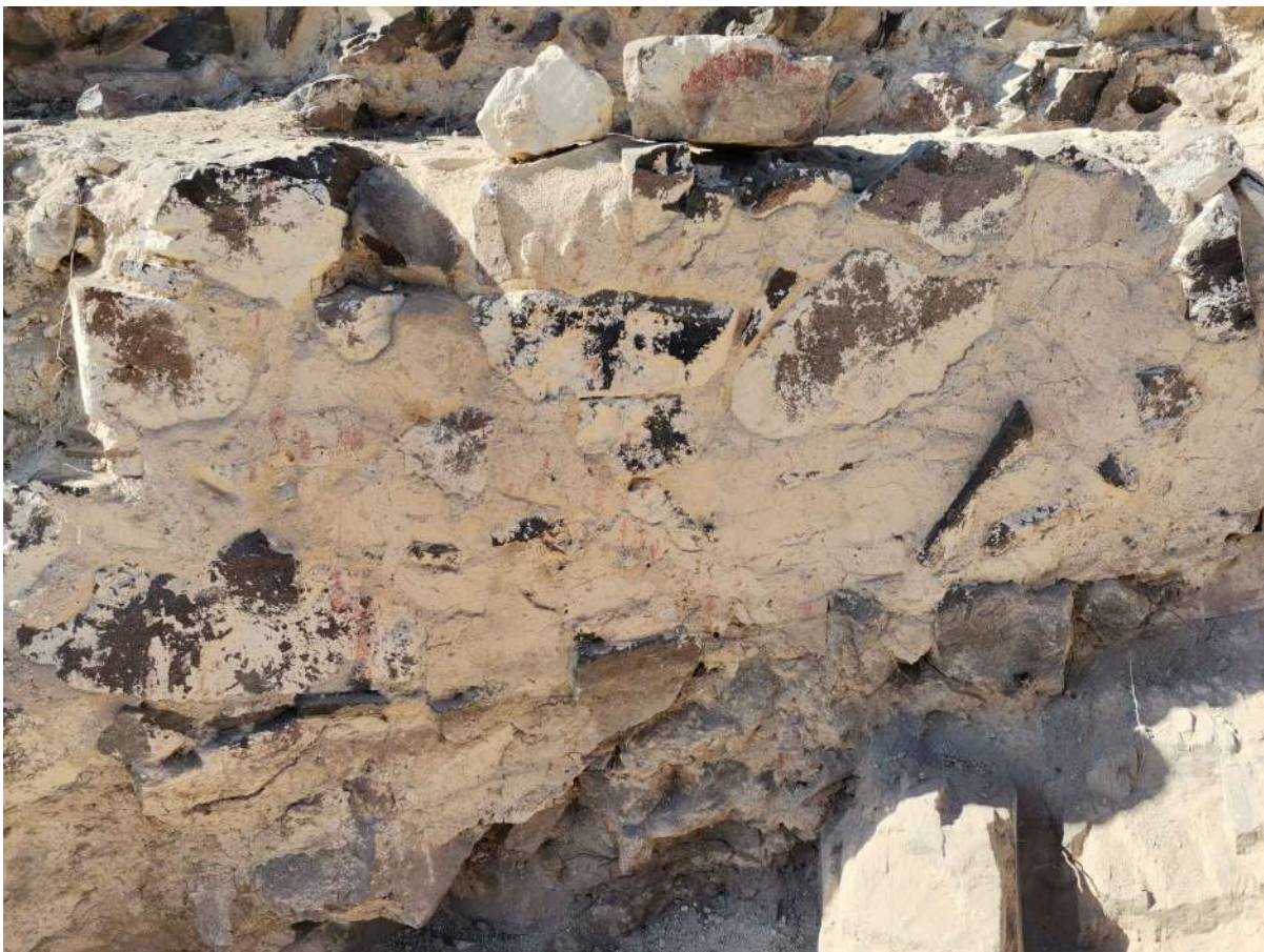
Fig. 28 - MONASTIR (SU) - Castello di Baratuli. Muro intonacato con tracce lineari rosse (foto G. Salis)
