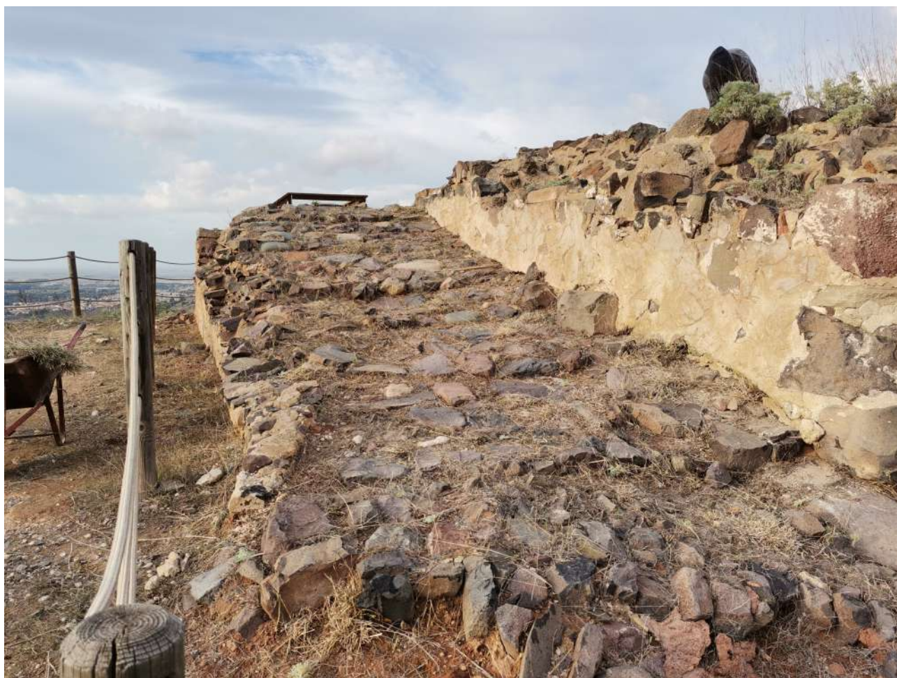
Fig. 11 - MONASTIR (SU) - Castello di Baratuli. Rampa di accesso lastricata (foto G. Salis)
