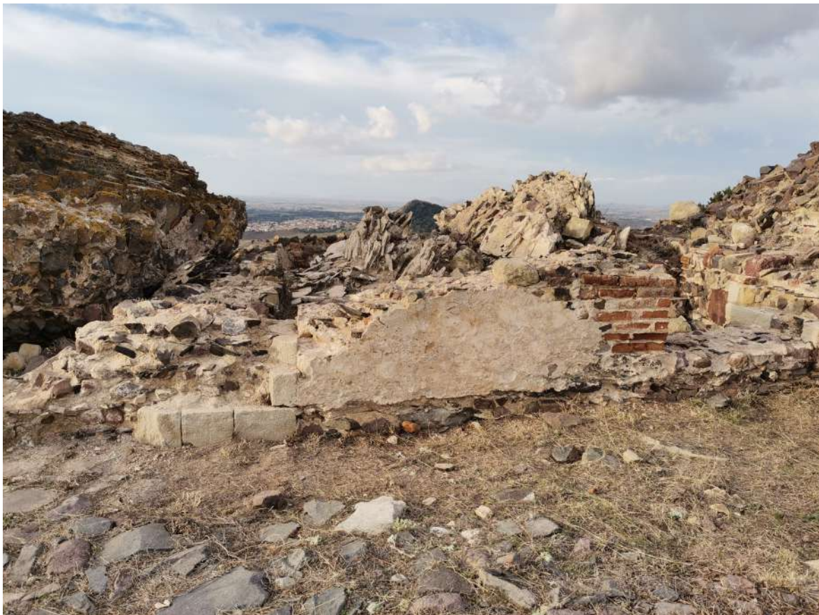
Fig. 22 - MONASTIR (SU) - Castello di Baratuli. Paramento murario sul cortile con parti intonacate (foto G. Salis)
