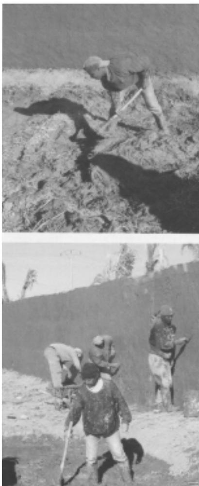
Fig. 23 - MAROCCO - Distretto di Er Rachidia: esempio di impastatoio per muratura in terra cruda (da CAVULLI 2008)
