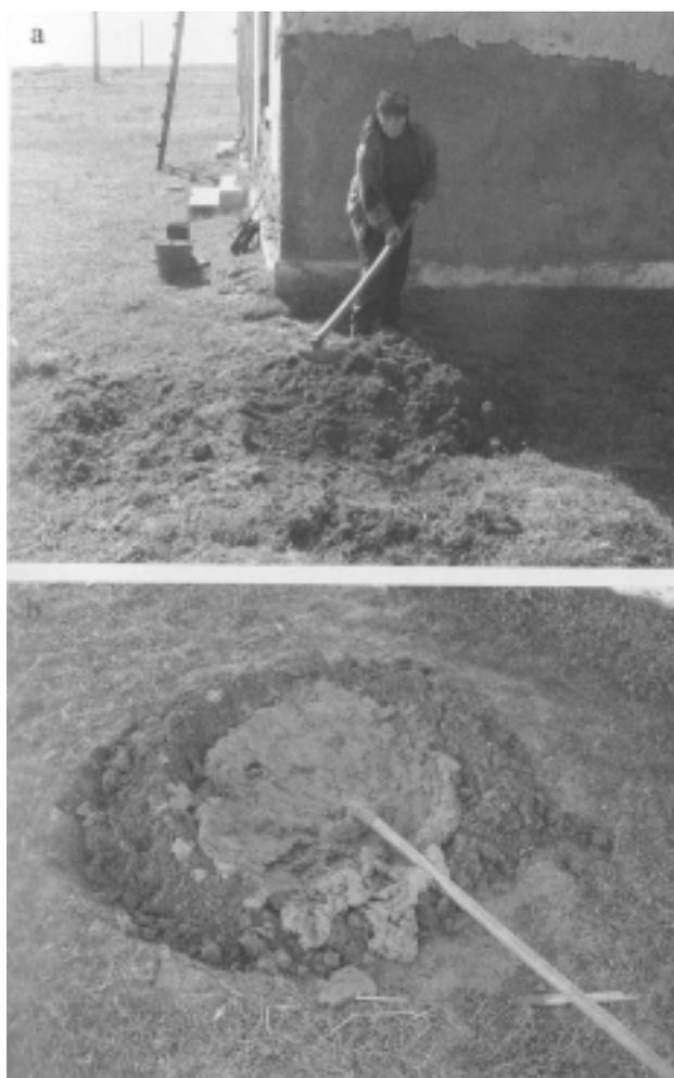
Fig. 24 - ROMANIA - Vadastra: estrazione e impasto di sedimento limoso per muratura in terra cruda (da CAVULLI 2008)
