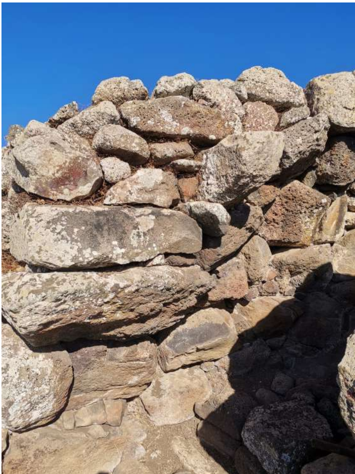
Fig. 6 - GESTURI - Bruncu Maduli. Corridoio. Particolare di blocchi che fuoriescono dal profilo del paramento interno (foto G. Salis).
