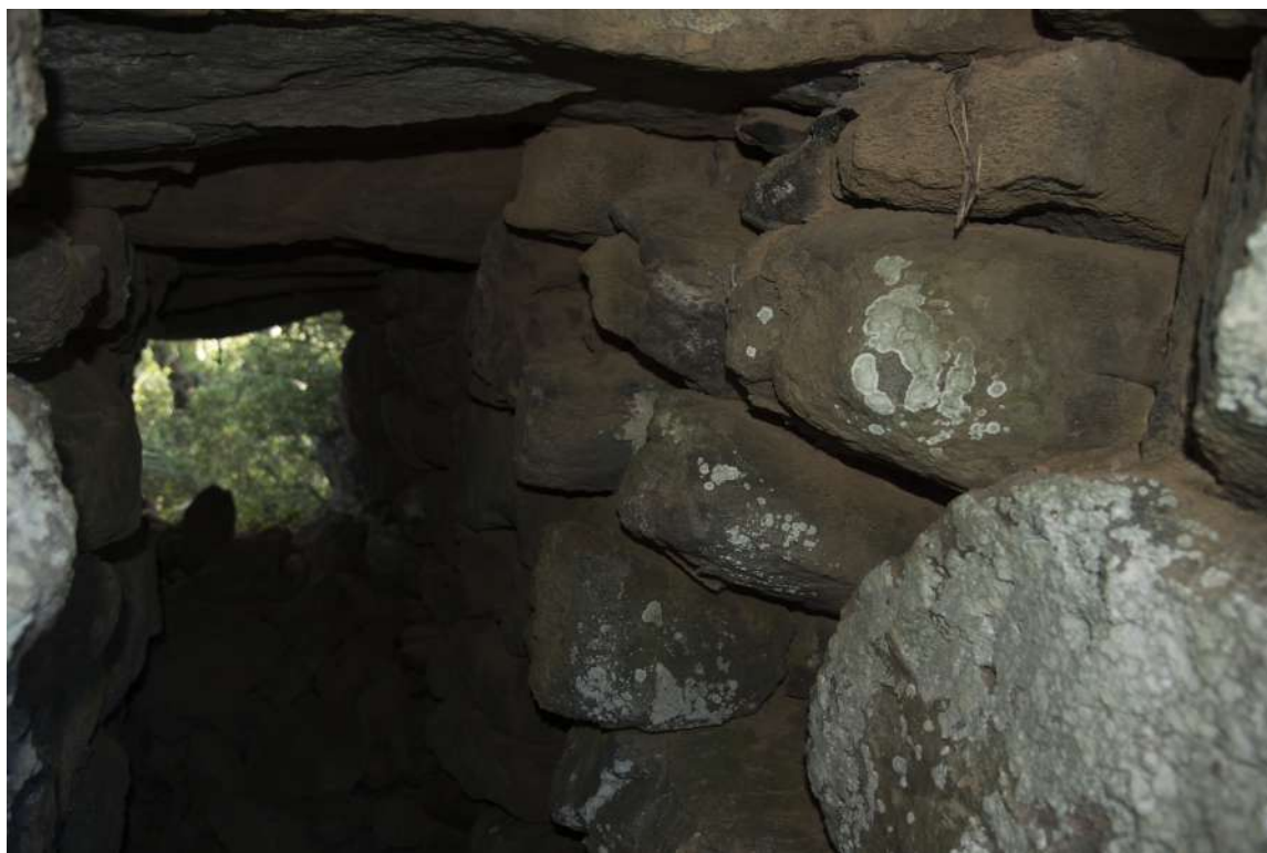
Fig. 20 - OLIENA - Gollei. Nuraghe a corridoio. Interno del corridoio (foto A. Congiu).
