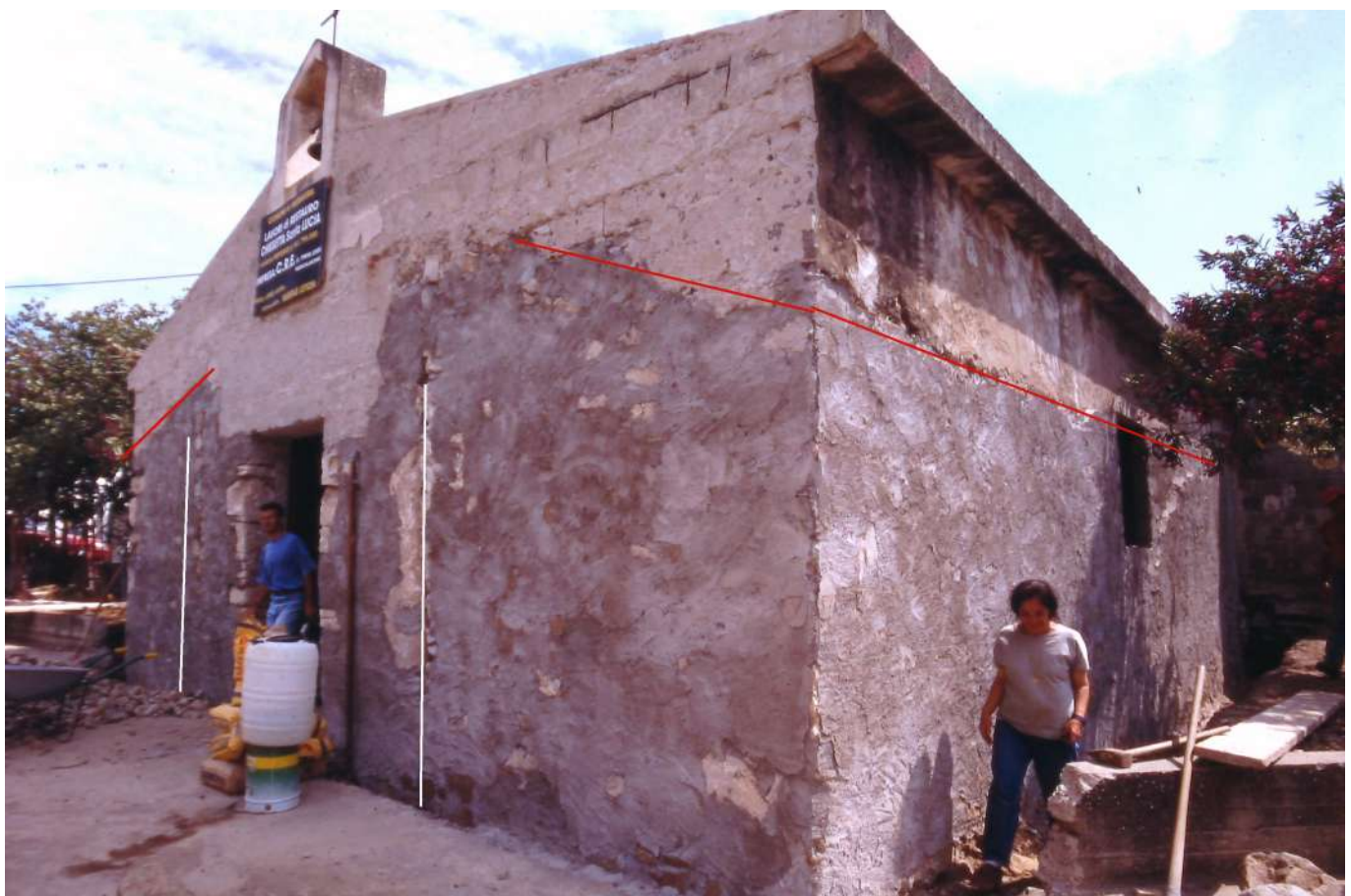
Fig. 2 - MURAVERA - Chiesa di Santa Lucia. La chiesa durante i lavori di restauro: la linea rossa segna la sopraelevazione degli anni Cinquanta, le due linee bianche la dimensione della facciata medievale (Archivio Salvi).
