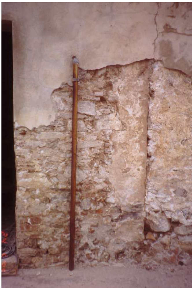
Fig. 3 - MURAVERA - Chiesa di Santa Lucia. Punto di contatto fra la muratura medievale e l'ampliamento settecentesco (foto D. Salvi).
