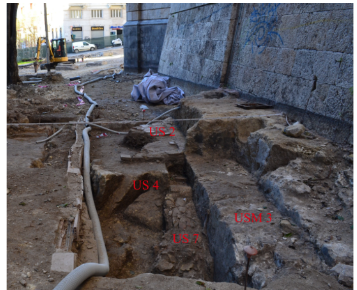
CAGLIARI – Piazza Costituzione - Viale Regina Elena. Area di scavo vista da Nord (foto M. Serra)
