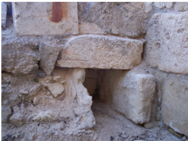
Fig. 17 - Cagliari, San Saturnino, Tomba singola a portello con copertura a lastre orizzontali (foto D. Salvi).
